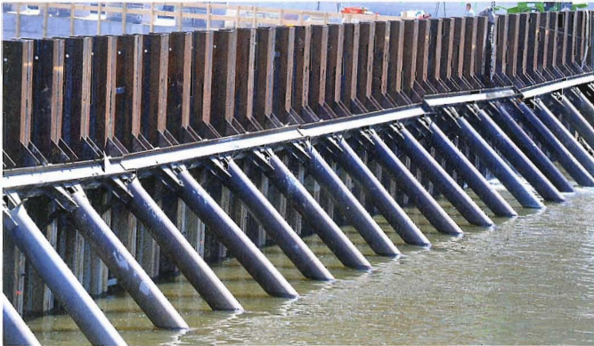
Bild 2. Detail der Spundwand
