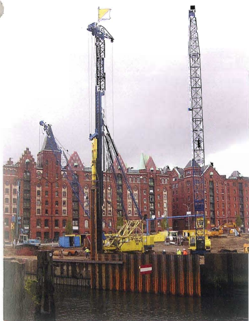
Bild 1. Rammen der Spundwand
