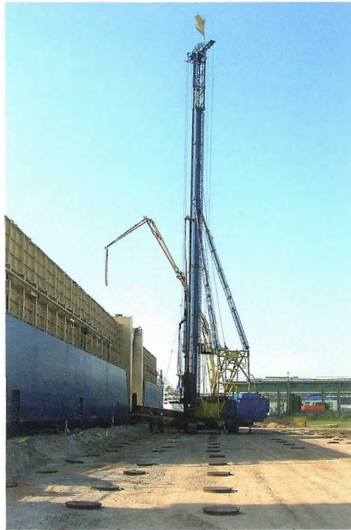
Bild 1. Rammgerät KH 180 GLS bei der Pfahlherstellung
