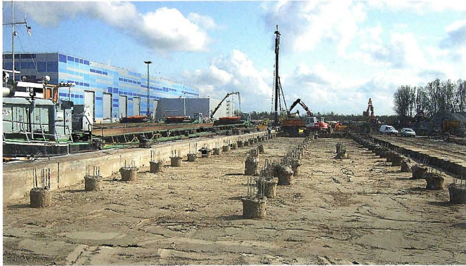
Bild 2. Freigelegte Pfahlköpfe vor dem Kappen (Fotos: Kurt Fredrich Spezialtiefbau)
