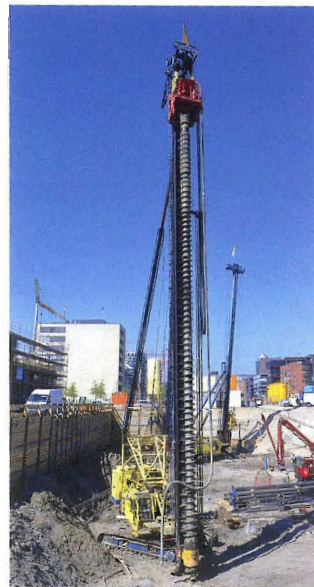
Bild 2. Gesamtansicht des Bohrgerätes mit 65 cm VSB-Schnecke (Fotos: Kurt Fredrich Spezialtiefbau)
