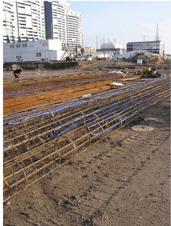
Bewehrungskörbe mit Doppelbelegung
