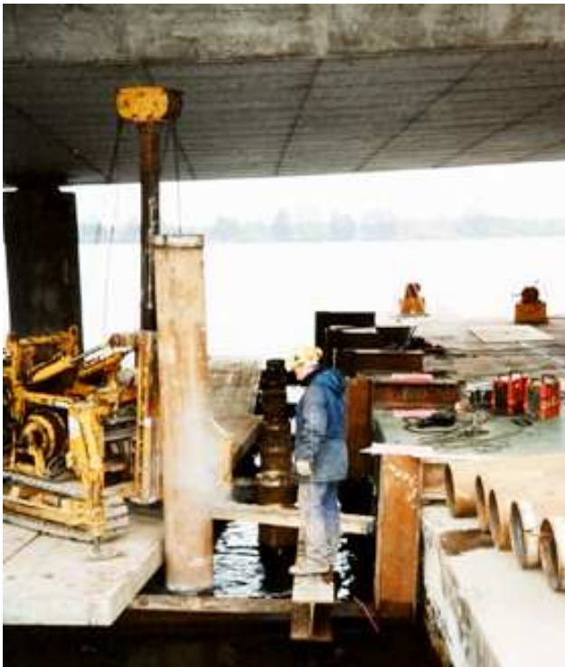
Einsatz "Miniramme" unter beschränkter Höhe - Ø 408 mm
