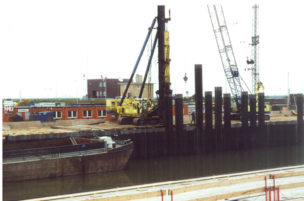
Einbringen der Tragbohlen
