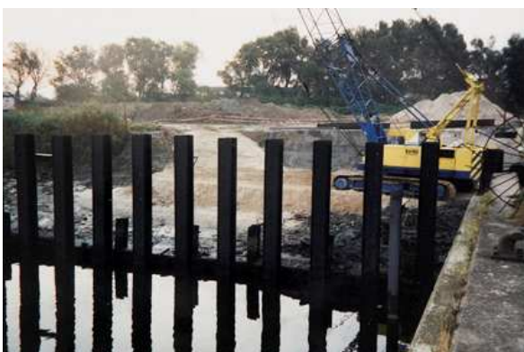
Eingebaute Tragbohlen
