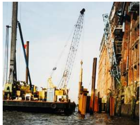
Einbringen einer kombinierten Spundwand vom Ponton
