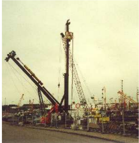
Mäklergeführtes Einrammen von Schrägpfählen
